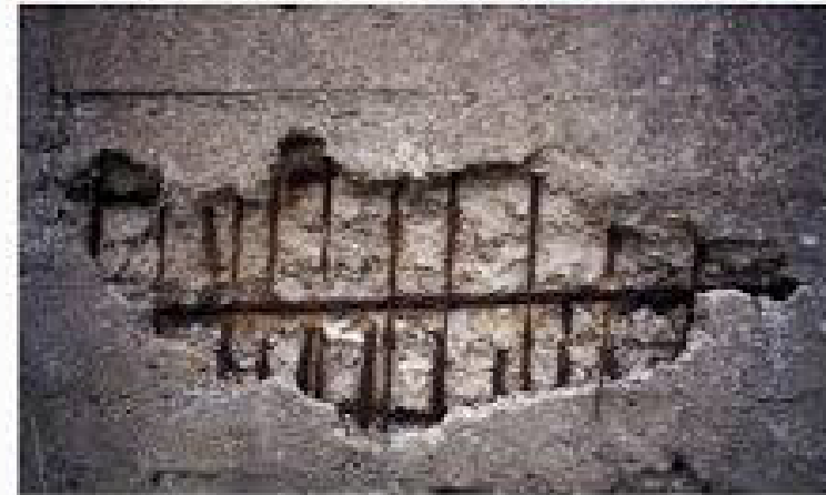
Spalling
